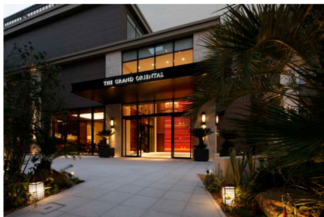
「グランドオリエンタルみなとみらい」外観
